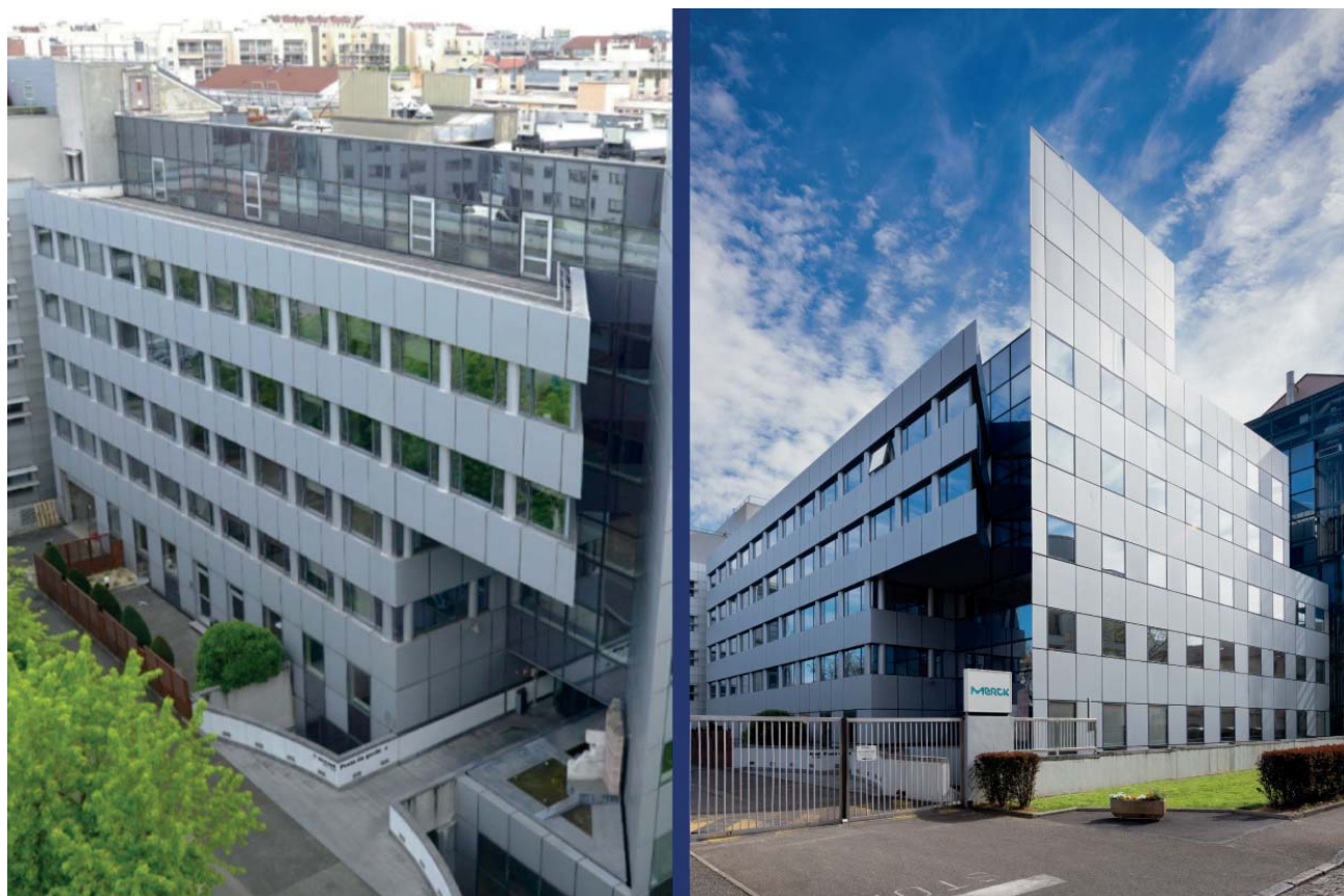
Immeuble TRIPTYK - rue Saint-Romain - Lyon 8 ème Crédit Photo : JLL
